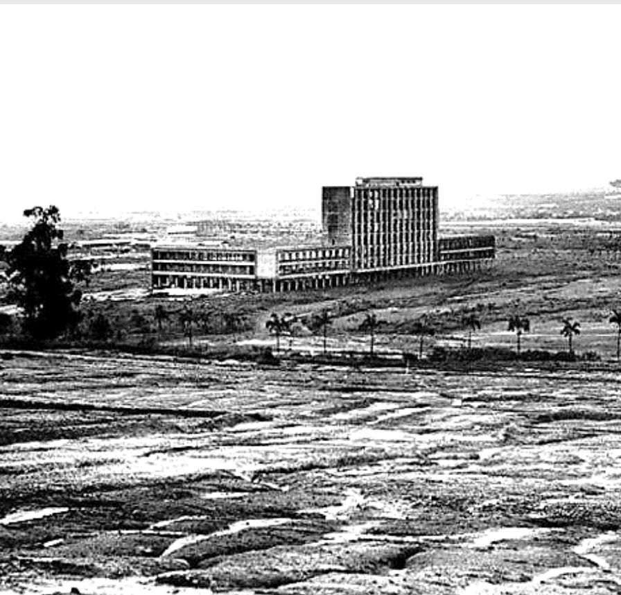
Estrutura do prédio da Reitoria, década de 1950.
